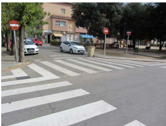
Imatge 40. Cruïlla entre el carrer Dom Bosco i el carrer Mossèn Cinto Verdaguer. Només amb pintura la cruïlla connecta de forma adequada els itineraris de vianants i compacta el punt de cruïlla, millorant també la seguretat dels vehicles. En fases posteriors es poden acabar de rebaixar els guals per fer-la accessible, fer orelles (més segures) o canviar la distribució dels carrers ampliant, per exemple, les voreres.
