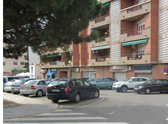
Imatge 44. Avinguda Diagonal. La semibateria inversa millora la visibilitat en la maniobra d'estacionament i sortida dels vehicles.
