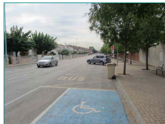
Imatge 57. Parada de bus oest a rambla del Sol.
