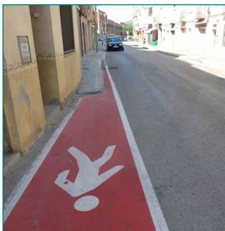
Imatge 52. Exemple d'itinerari de vianants en calçada a Olesa de Montserrat.
