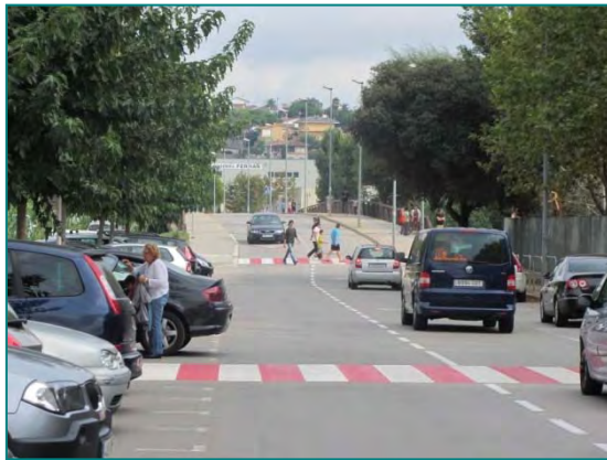
Imatge 66. Pas de vianants amb reforç de pintura, en principi per connectar aparcament amb vorera, tot i que no hi ha itinerari de vianants
