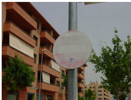
Senyal en estat deficient
