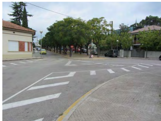
Imatge 42. La configuració de la cruïlla, tot i no ser perillosa pels vehicles, és totalment inadequada per als vianants.
