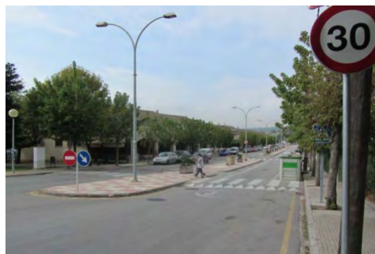
Imatge 14. Carrer Arquitecte Falguera. Passos de vianants elevats, en l'accés des de l'Avinguda Catalunya per reduir la velocitat.
