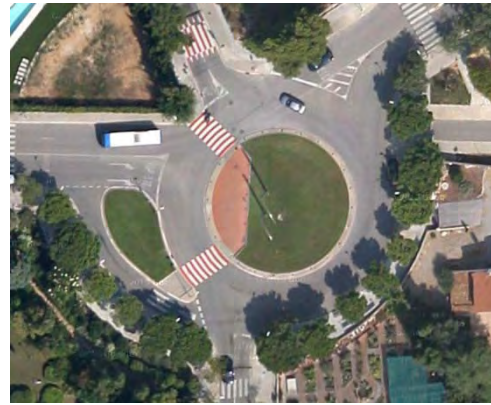
Imatge 48. Pas de vianants en rotonda urbana a Esplugues de Llobregat.
