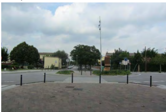
Imatge 13. Carrer Issac Peral amb carrer Can Cortés. Cruïlla-rotonda elevada per a la reducció de la velocitat dels vehicles i major seguretat.
