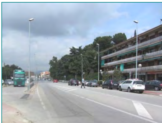
Imatge 19. Cruïlla amb el carrer de Can Cortés, amb tercer carril de gir a l'esquerra i incorporació.
