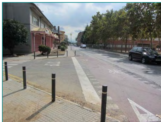
Imatge 62. Carrer Folch i Torres amb carrer de Barcelona. Pas de vianants no lineal amb l'itinerari a peu.
