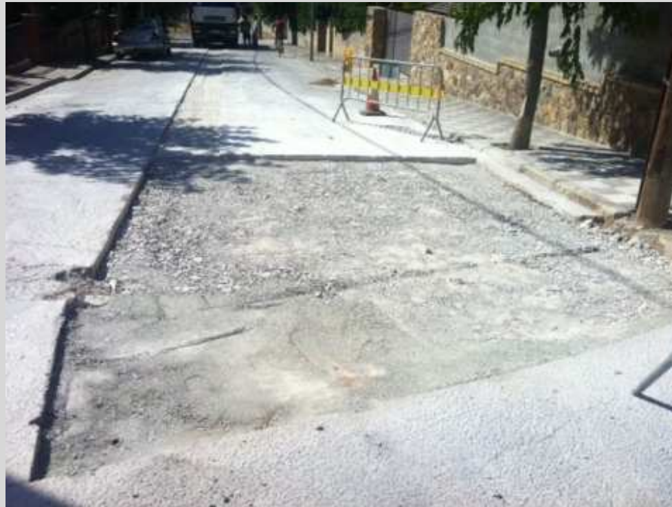
Arranjament d'asfaltat al C/ La Pujada
