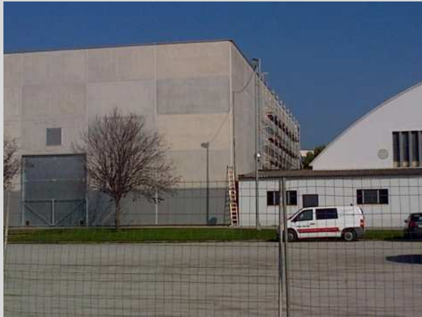
Segellat de les juntes de la façana del pavelló ( 12.677,17€ )
