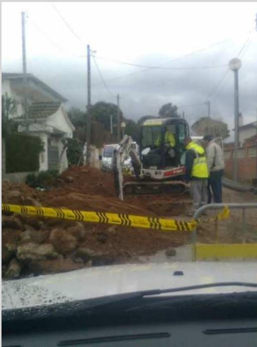
Reparació del clavegueram al carrer de Numància
