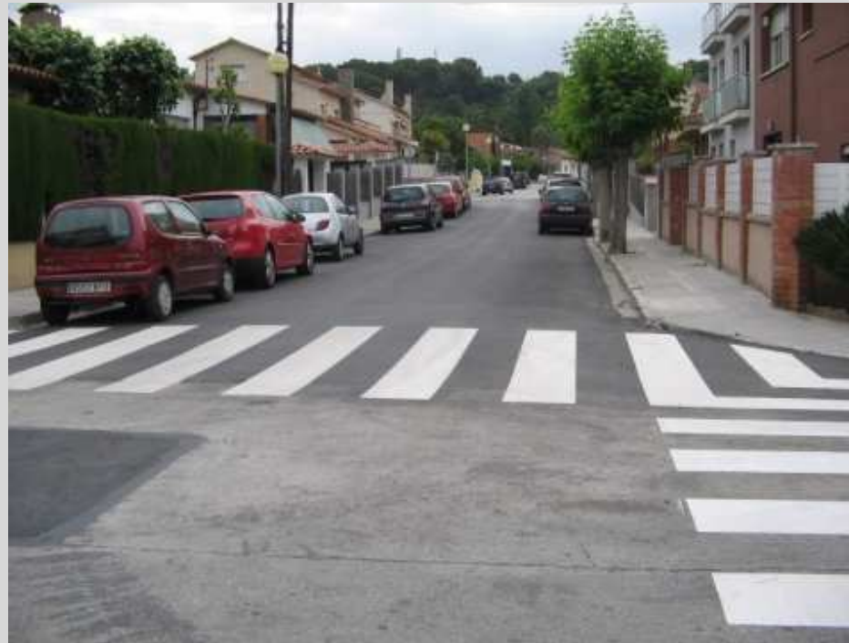
Reparació d'asfaltat al Carrer St. Miquel
