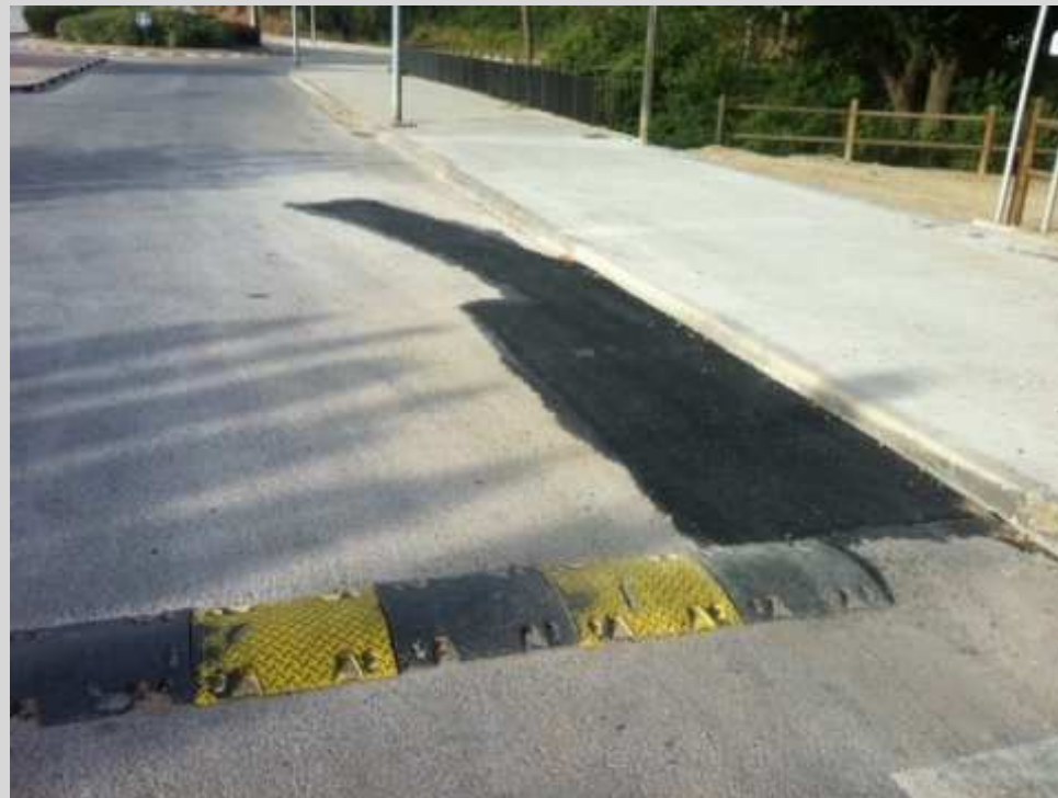
Arranjament d'asfaltat al Camí de Can Riera
