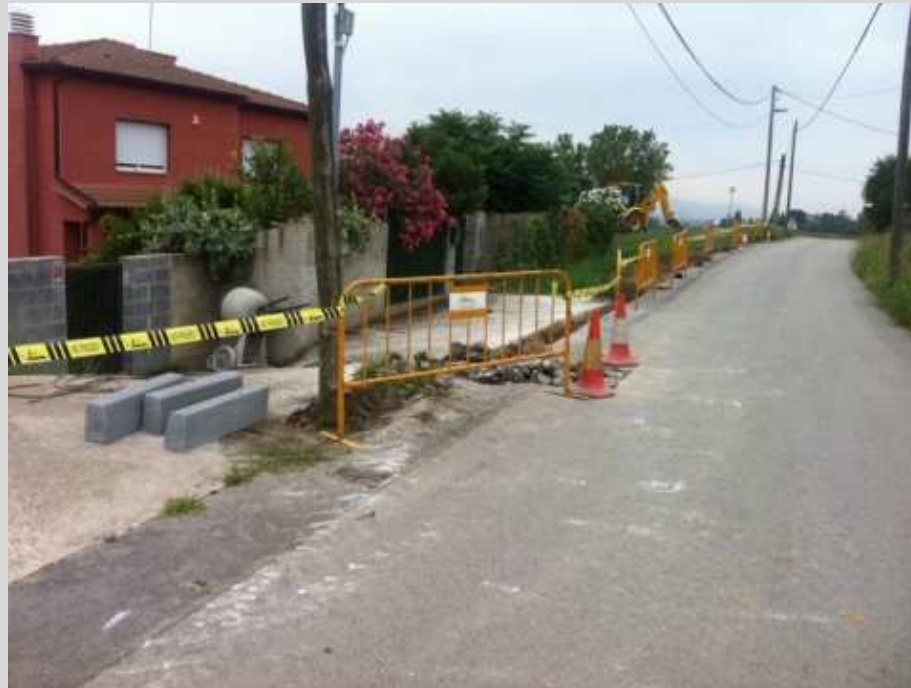
Millora d'un tram de cuneta en el carrer Susqueda
