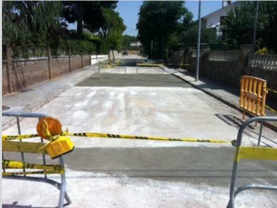
Arranjament paviment de formigó al Carrer Cirera
