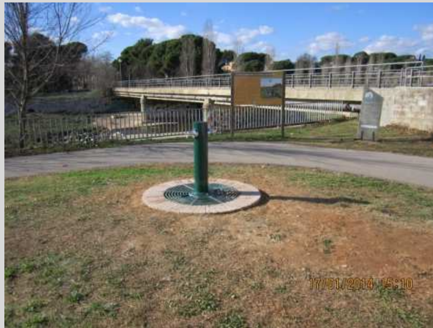
Col.locació d'una font a l'entrada de la Rda. Verda ( Obres executades per la brigada municipal )
