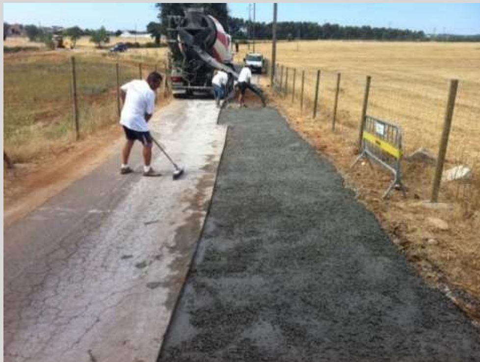
Arranjament d'asfaltat al Camí de St.Roc
