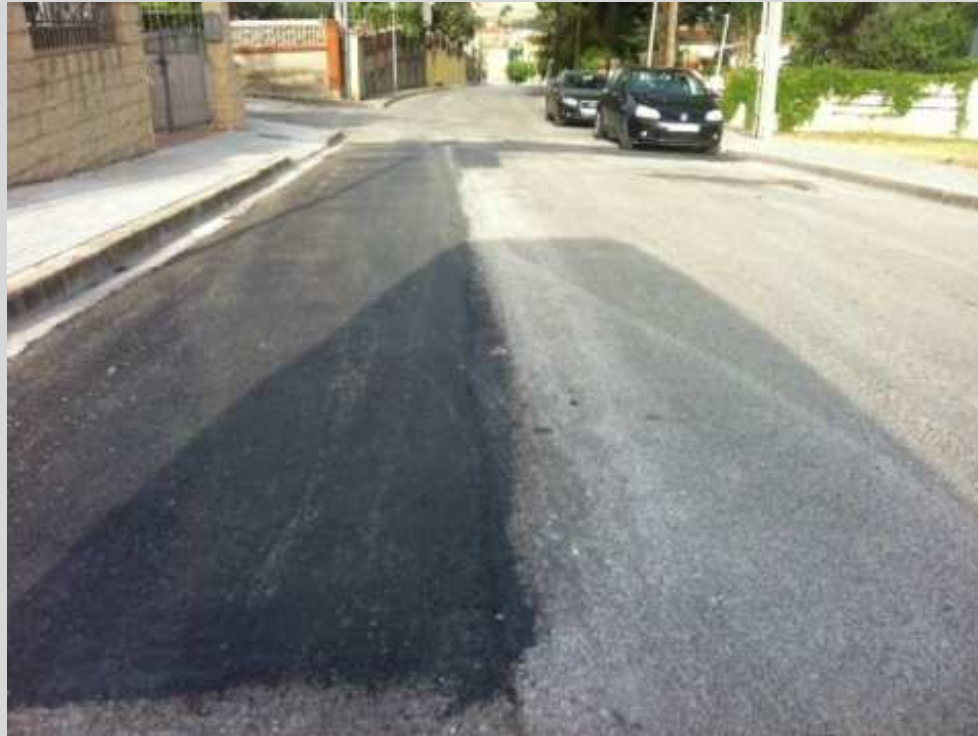
Arranjament d'asfaltat al Carrer Arimón
