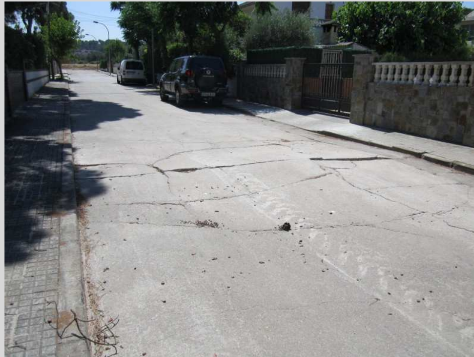
Reparació del paviment del C/ Cirera
