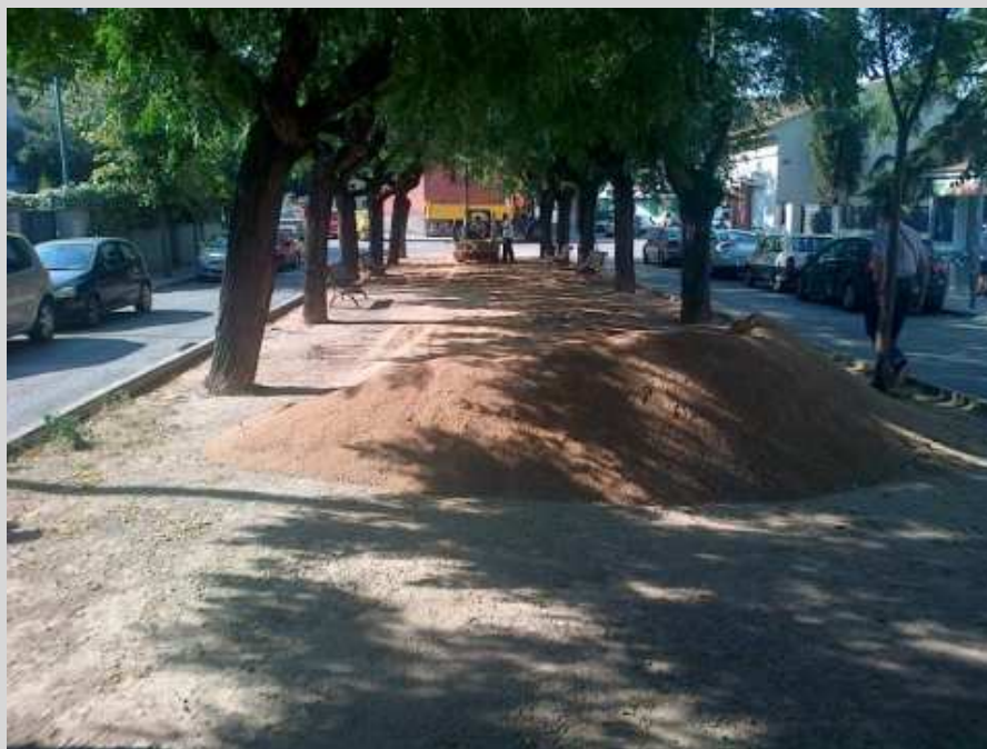
Arranjament del sauló de la Rbla. Nostra Senyora de Montserrat
