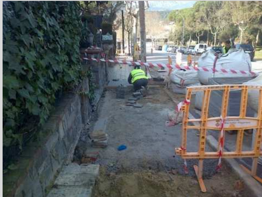
Reparació de voreras a l'Av. Folch i Torres ( Obres executades per la brigada municipal )
