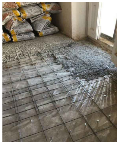
DETALL XAPA COMPRESSIÓ AMB CONECTORS
