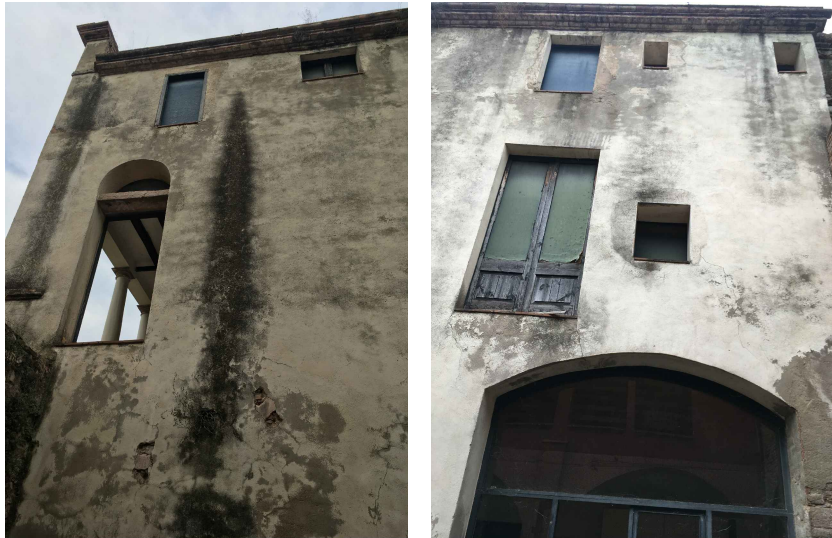
FAÇANA EST EXISTENT MASIA CAN MAIOL
