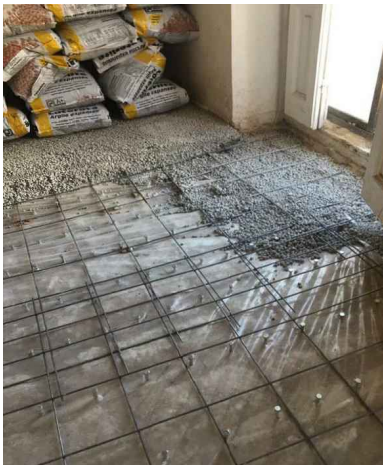
DETALL XAPA COMPRESSIÓ AMB CONNECTORS
