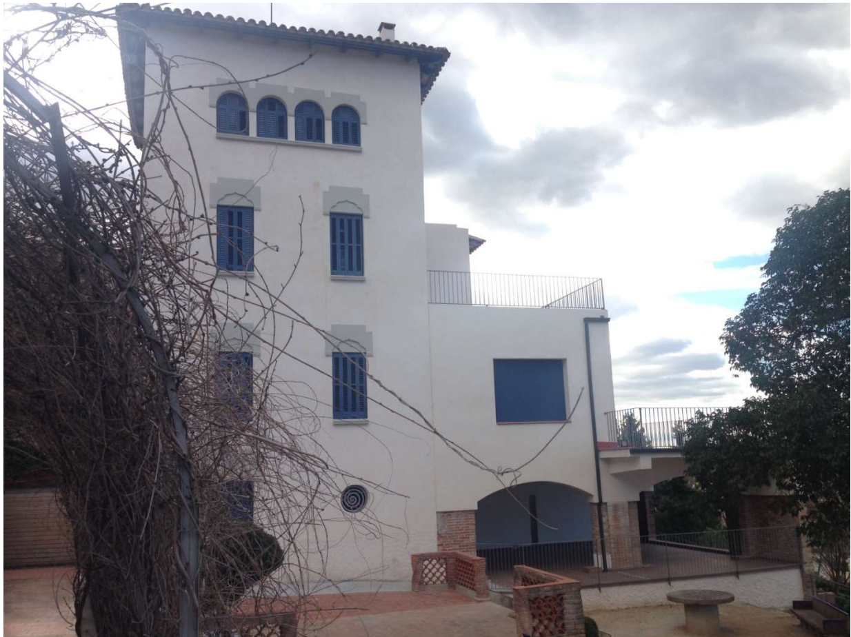
Façana de la Torre Folch, que es posarà en ús Octubre 2021 com a Viver Cultural
