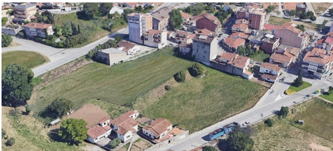
Vista del sector des de l'extrem nord-oest, amb el carrer del Camí Reial en primer terme
