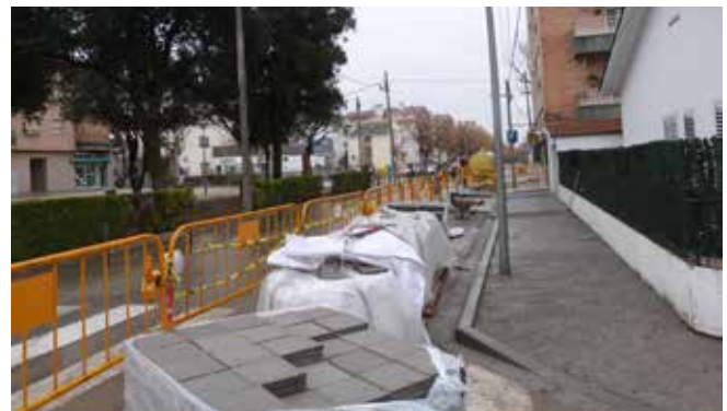
Renovació de voreres al carrer Dom Bosco
