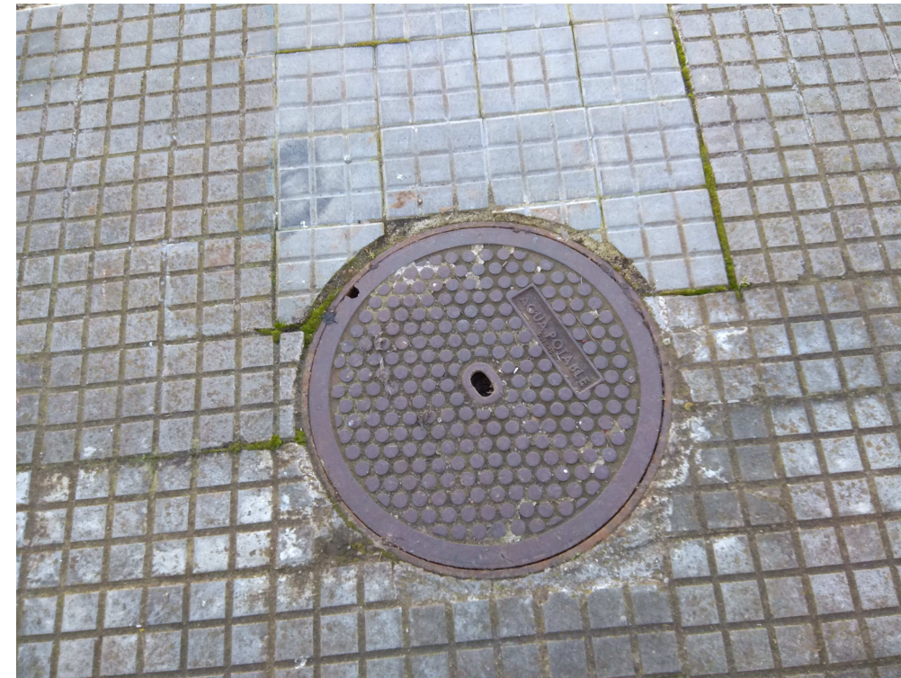
Figura 3: Registre on s'ubica el cabalímetre. Punt inicial de la nova canonada
