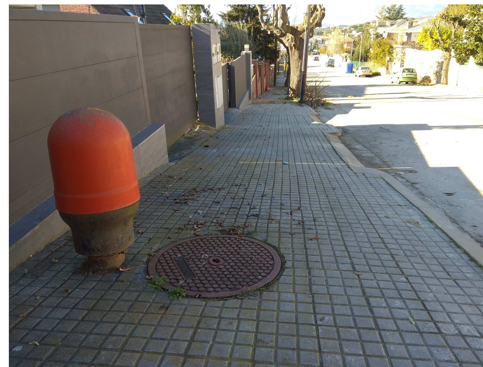
Figura 3: Registre on s'ubica el cabalímetre. Punt inicial de la nova canonada
