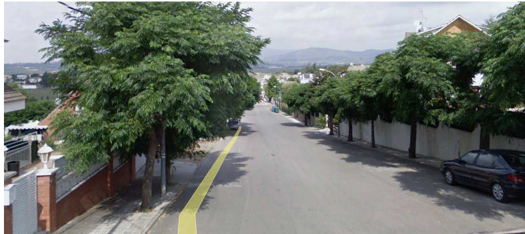
Figura 3: Carrer on s'instal·larà la canonada, amb molt poc volum de trànsit
